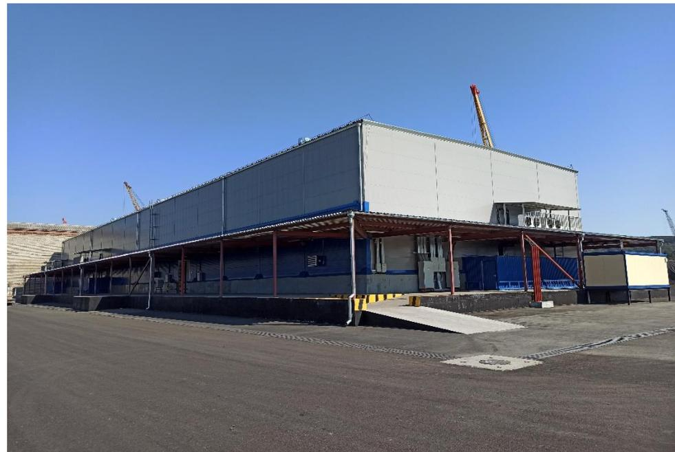
**Описание:** Металлический каркас с ограждающими конструкциями из сэндвич-панелей на минераловатном наполнителе.
