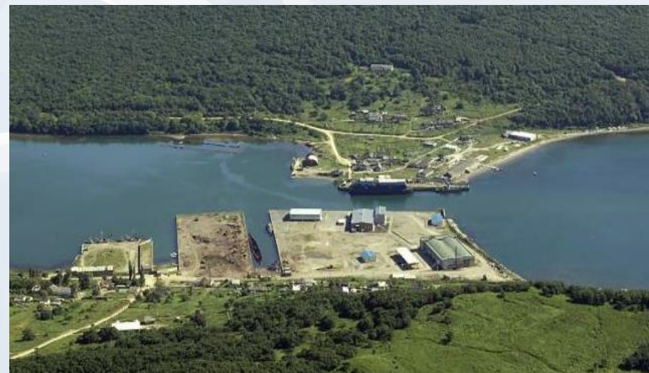
Строительство новой судовой верфи
